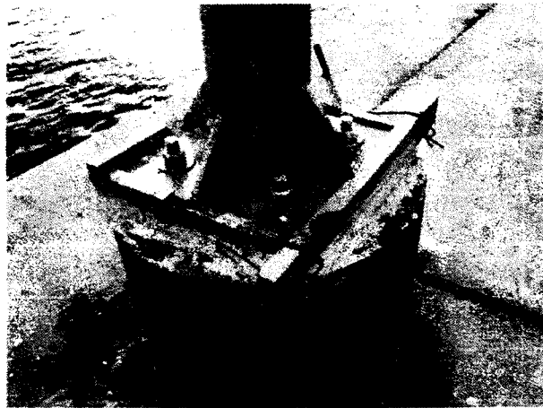
Imagen N° 5 Encofrado para grouting
