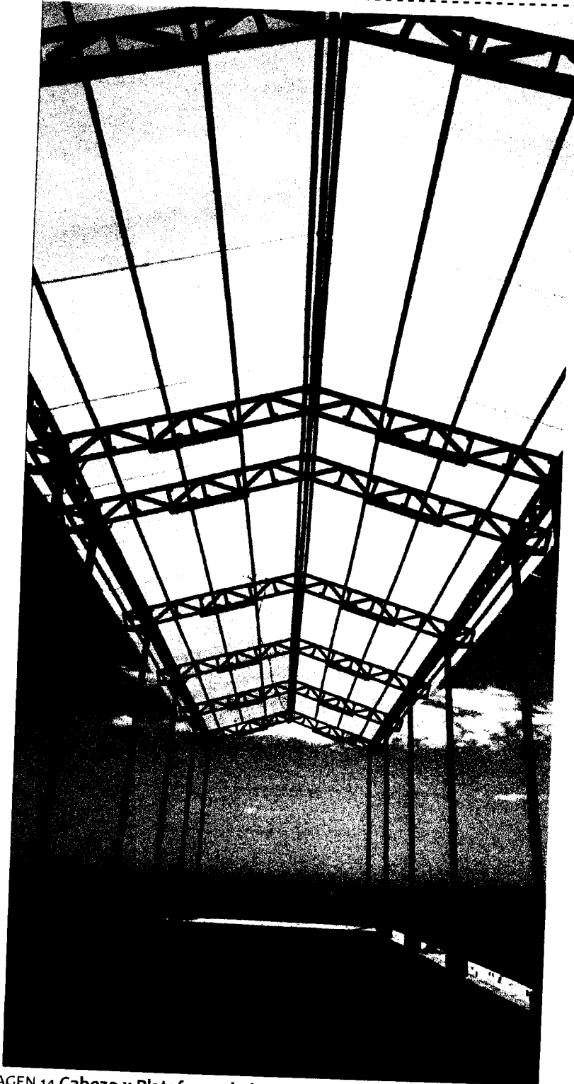
IMAGEN 14 Cabezo y Plataforma baja con cobertura e instalación eléctrica.
